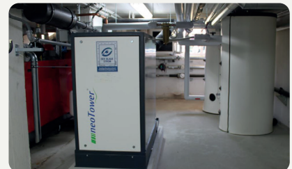
Abb.: Einzelne Blockheizkraftwerke des Energieeffizienzportfolios mit entsprechender Schallschutzverkleidung im Keller der jeweiligen Immobilien.
