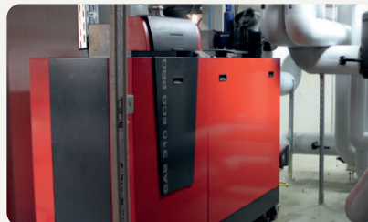
Abb.: Einzelne Blockheizkraftwerke des Energieeffizienzportfolios mit entsprechender Schallschutzverkleidung im Keller der jeweiligen Immobilien.
